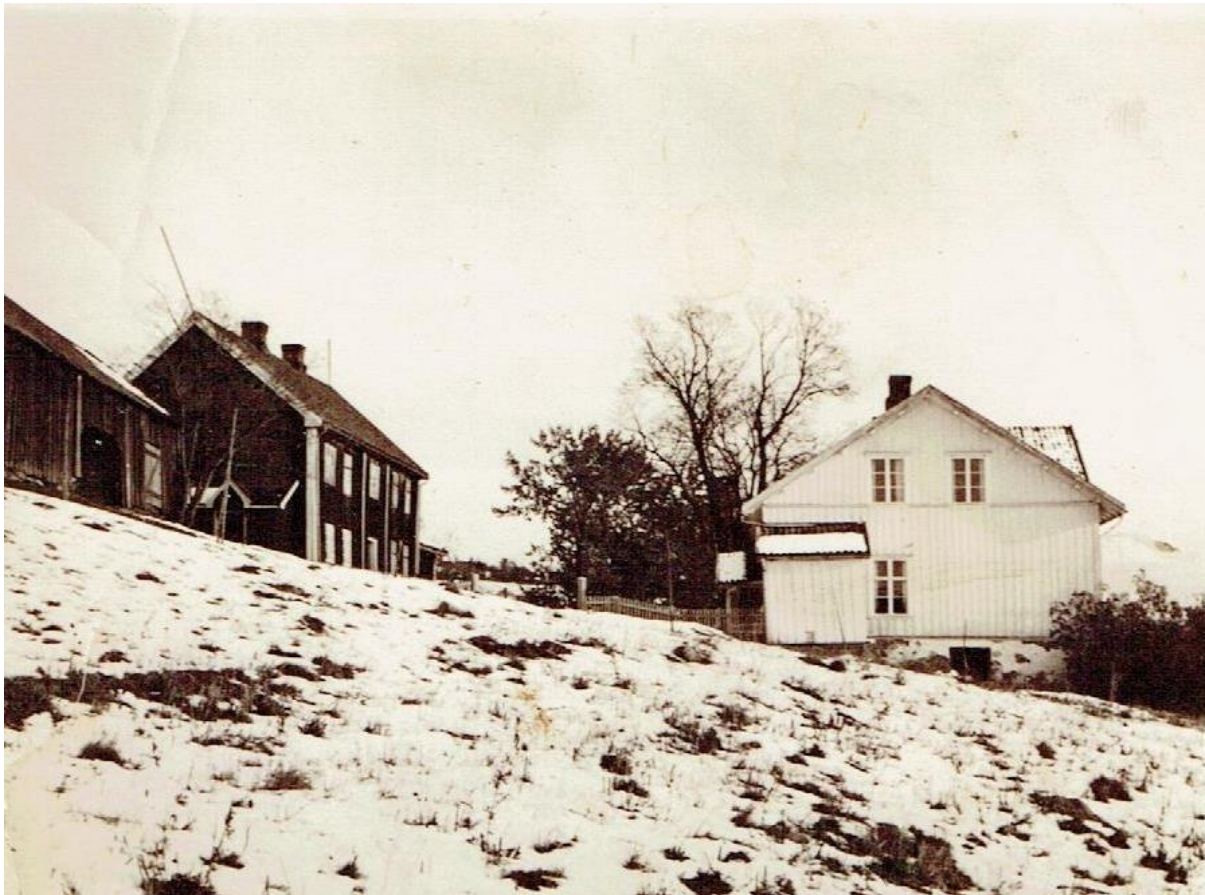
Prestegarden i Vardal. Til høyre: presteboligen, til venstre: skålen og forpakterboligen.
