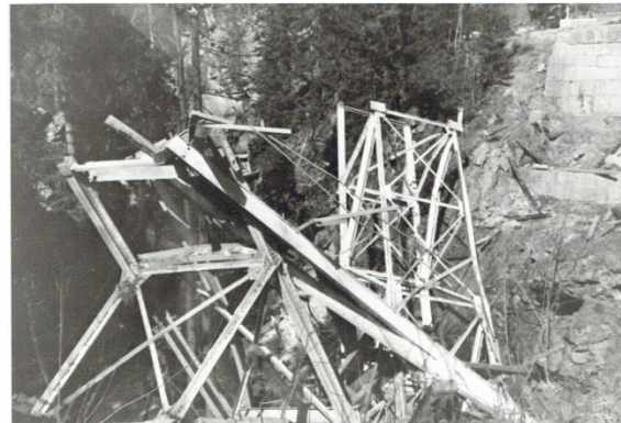
Bråstadbrua ble sprengt 19. april.
