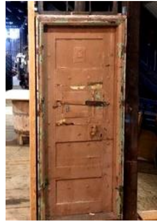
Celledør oppsatt i Prestegardslåven
