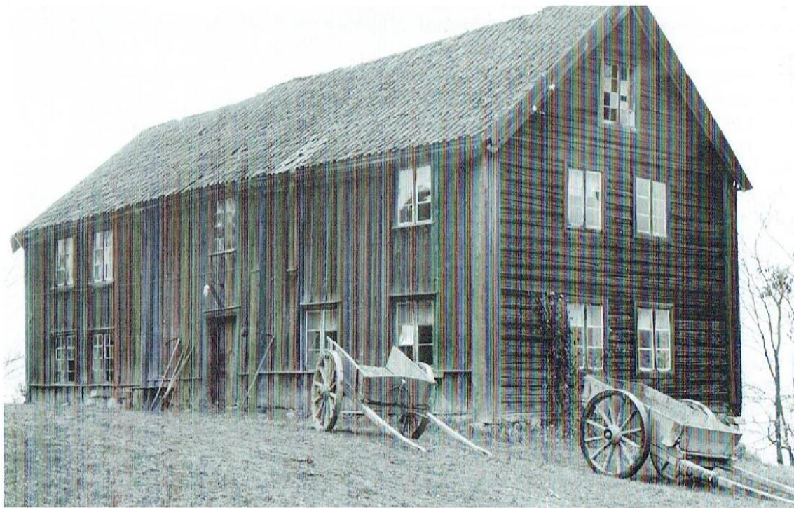
Huset på Svartåsen hvor Antonette vokste opp. Her ble hun også obdusert av distriktslege Raabe. Foto fra 1953 før bygningen ble flyttet til Eiktunet museum.
