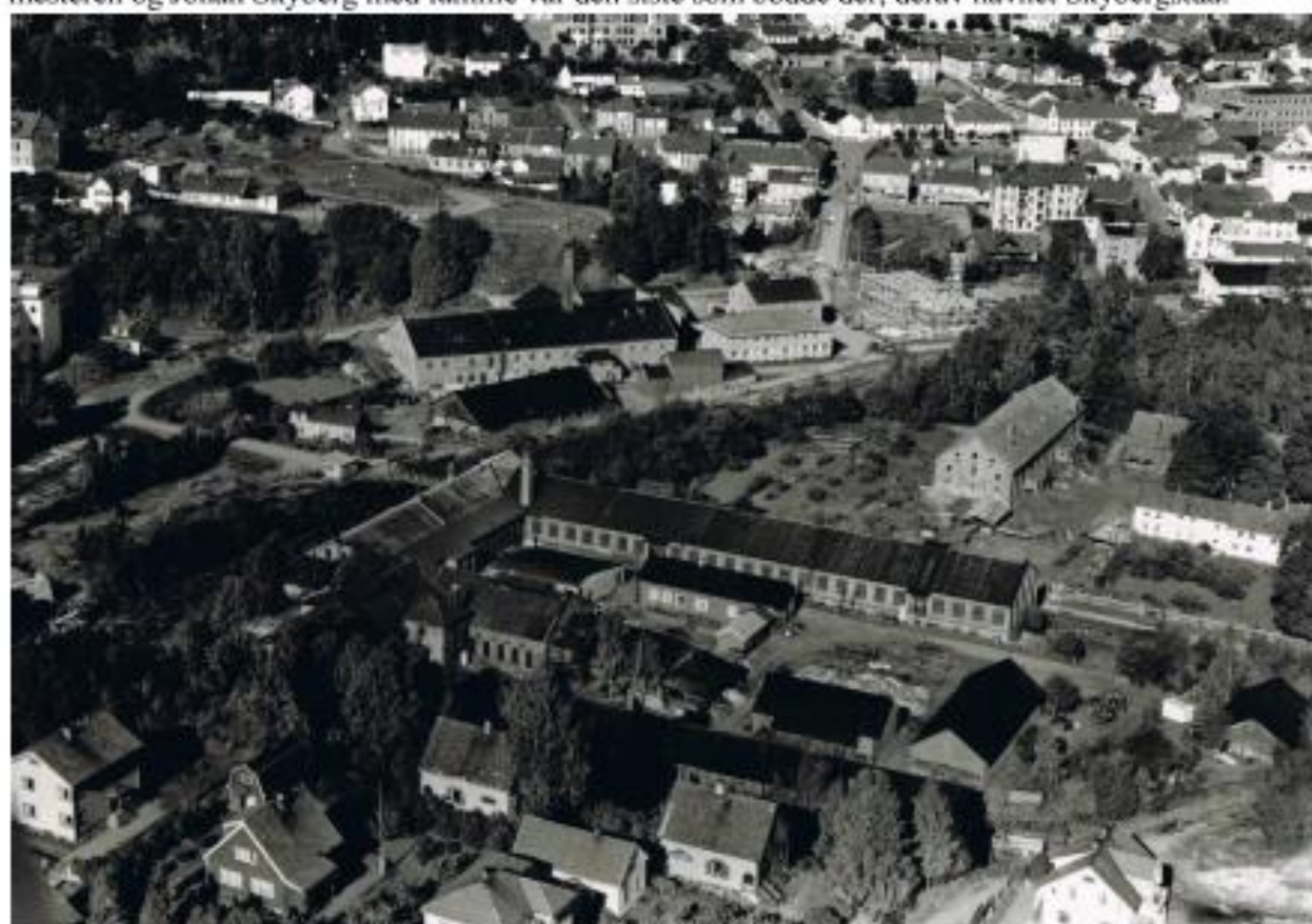
Skybergstua i 1952. Kornsiloen under bygging i bakgrunnen.
