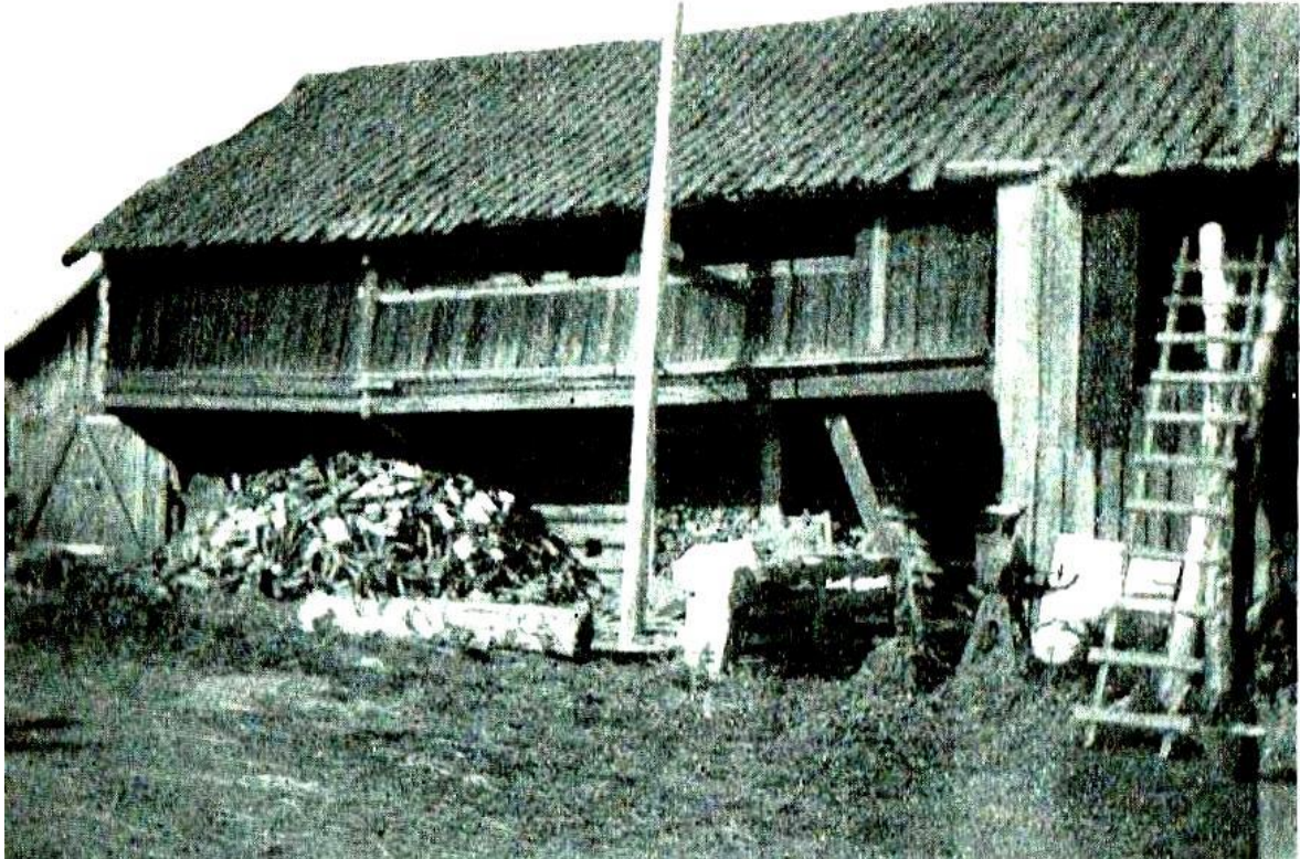
Langloftet på Øvre Gjøvik før flytting. Foto: Vardal Bygdebok
