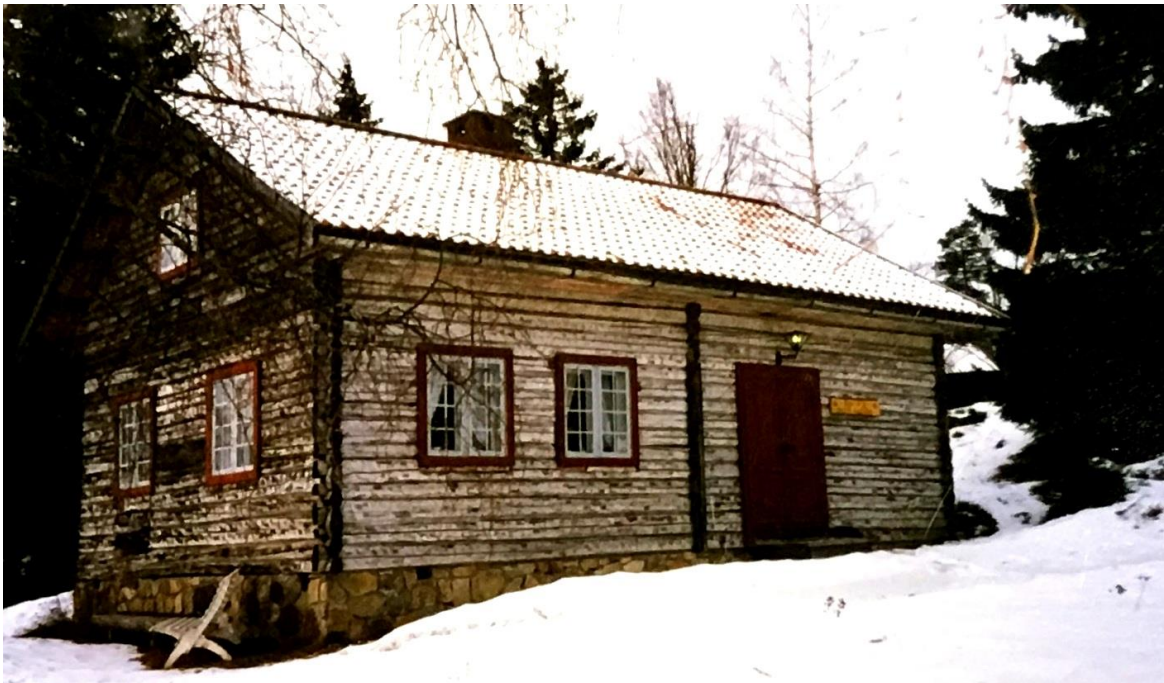
Vårnesbygningen før veggene ble rappet. Foto: Eiktunet
