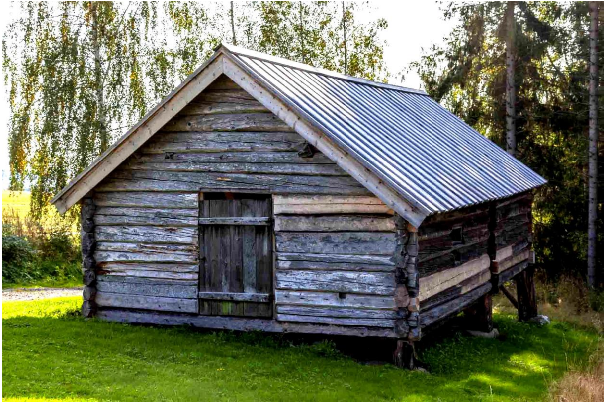
Fjøset på Drogsethsetra ble restaurert i 2018. Foto: Audbjørn Rønning
