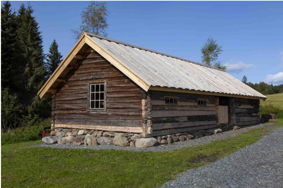
Størhuset ble restaurert i 2019. Foto: Audbjørn Rønning
