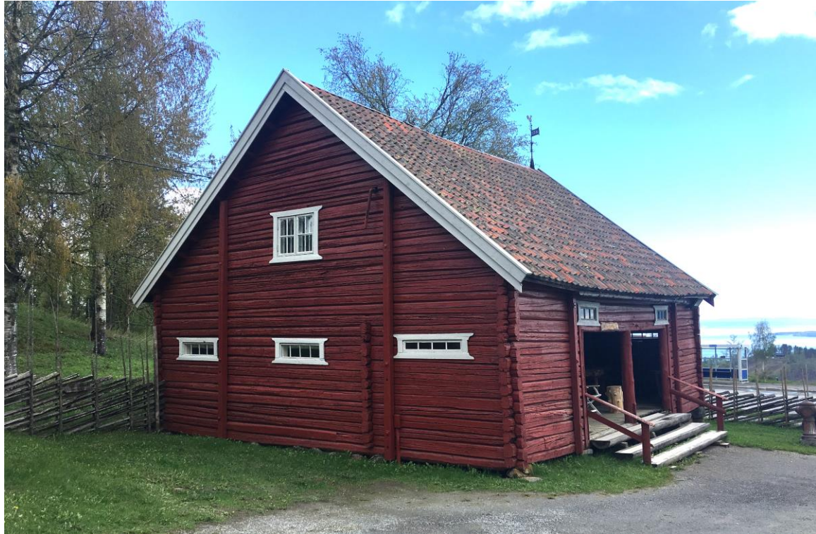
Stabburet fra Nerby blir bl. a. benyttet til snekkerverksted for Gjøvik Husflidlag. Foto: Arve Thune
