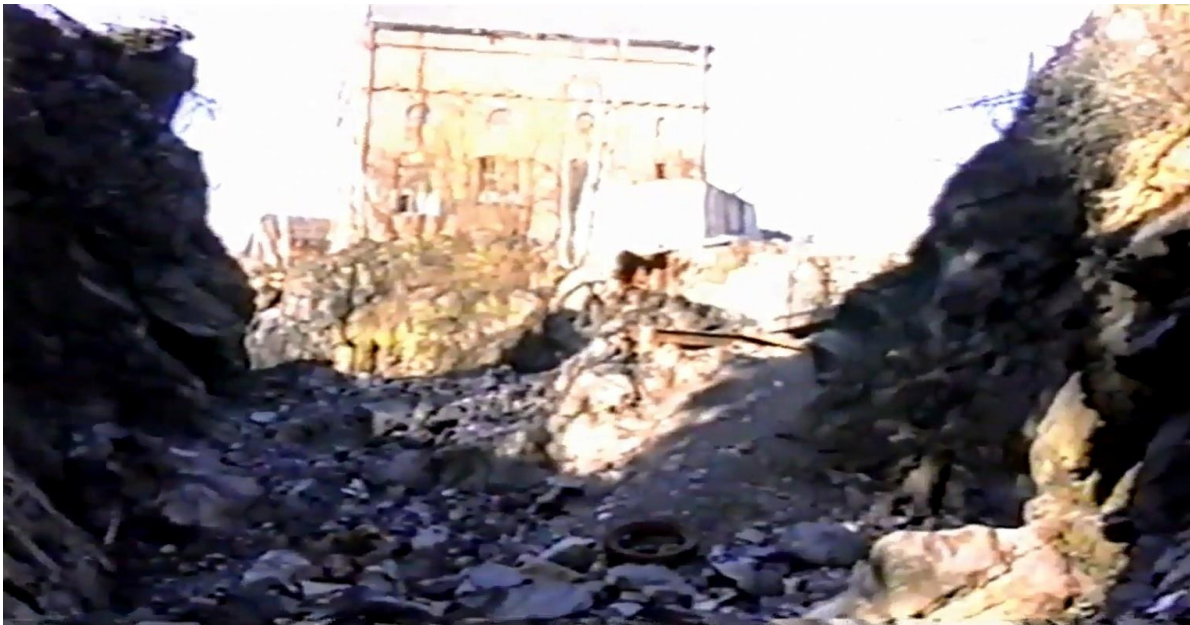
Elvebunnen nedenfor Brufoss før riksveg 4 ble bygget
