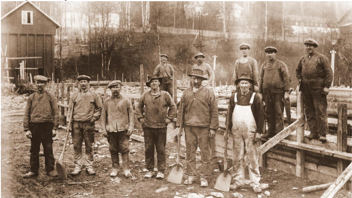
Ute i Europa kjøpte Mustad opp den ene fabrikken etter den andre, og hjemme på Brusveen måtte det stadig utvidelser til. Her er grunnarbeidene i gang for oppføring av en ny fabrikkbygning. I første rekke fra venstre: Oluf Grønland, Magnus Vifladt, Maurits Vilberg, Ole Lønstad (Høgden), J. O. Svendsen og Kristian Næsset. Bak: Andreas Berg, Anders Evensen, Klaring Aas, Thorolf Hagestuen og Thorleif Hagestuen. Bildet er tatt cirka 1920.
