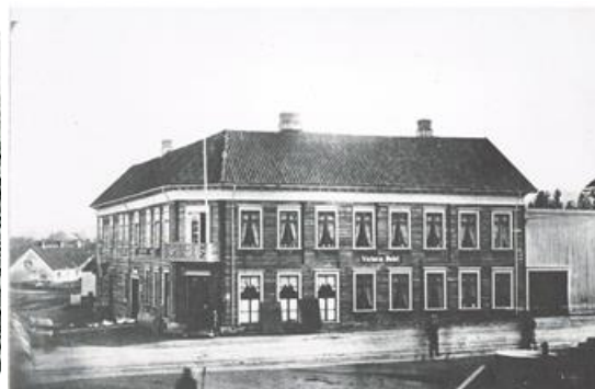
Enkehuset fra glassverkstiden ses i bakgrunnen
